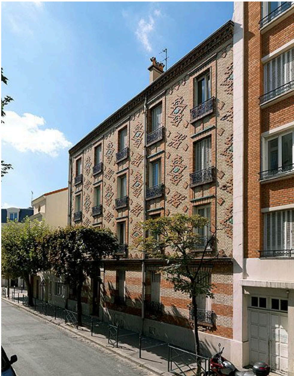
92, La Garenne-Colombes, immeuble , 34 rue Voltaire. La façade de brique à motifs polychromes vue de la rue.
