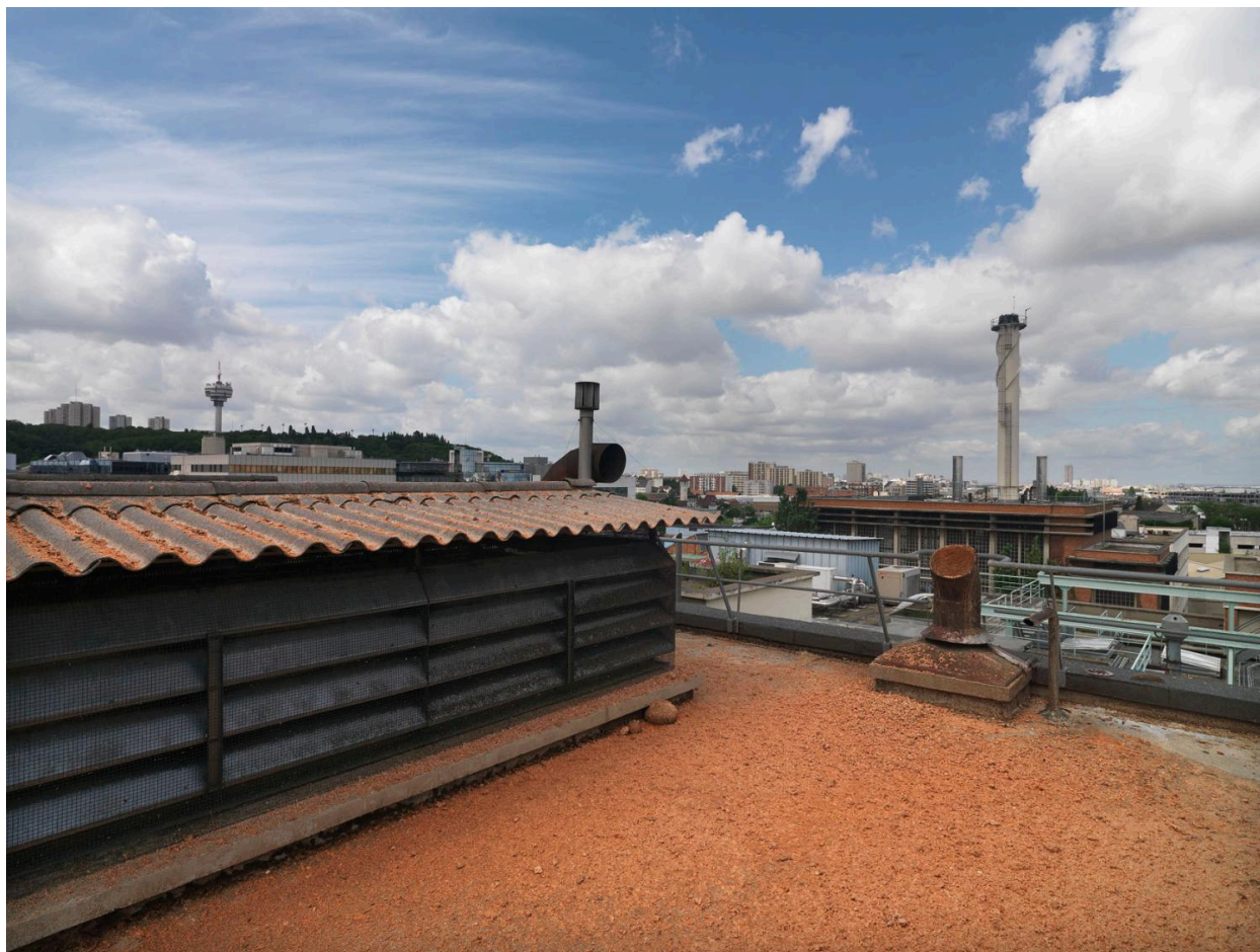
Site Sanofi. Vue des toits.
