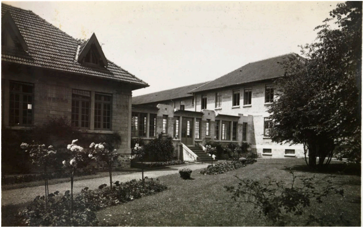
Vue de la galerie longitudinale reliant le bâtiment central et les quatre divisions. (Archives de l'Assistance publique, 3 Fi 3/20)
