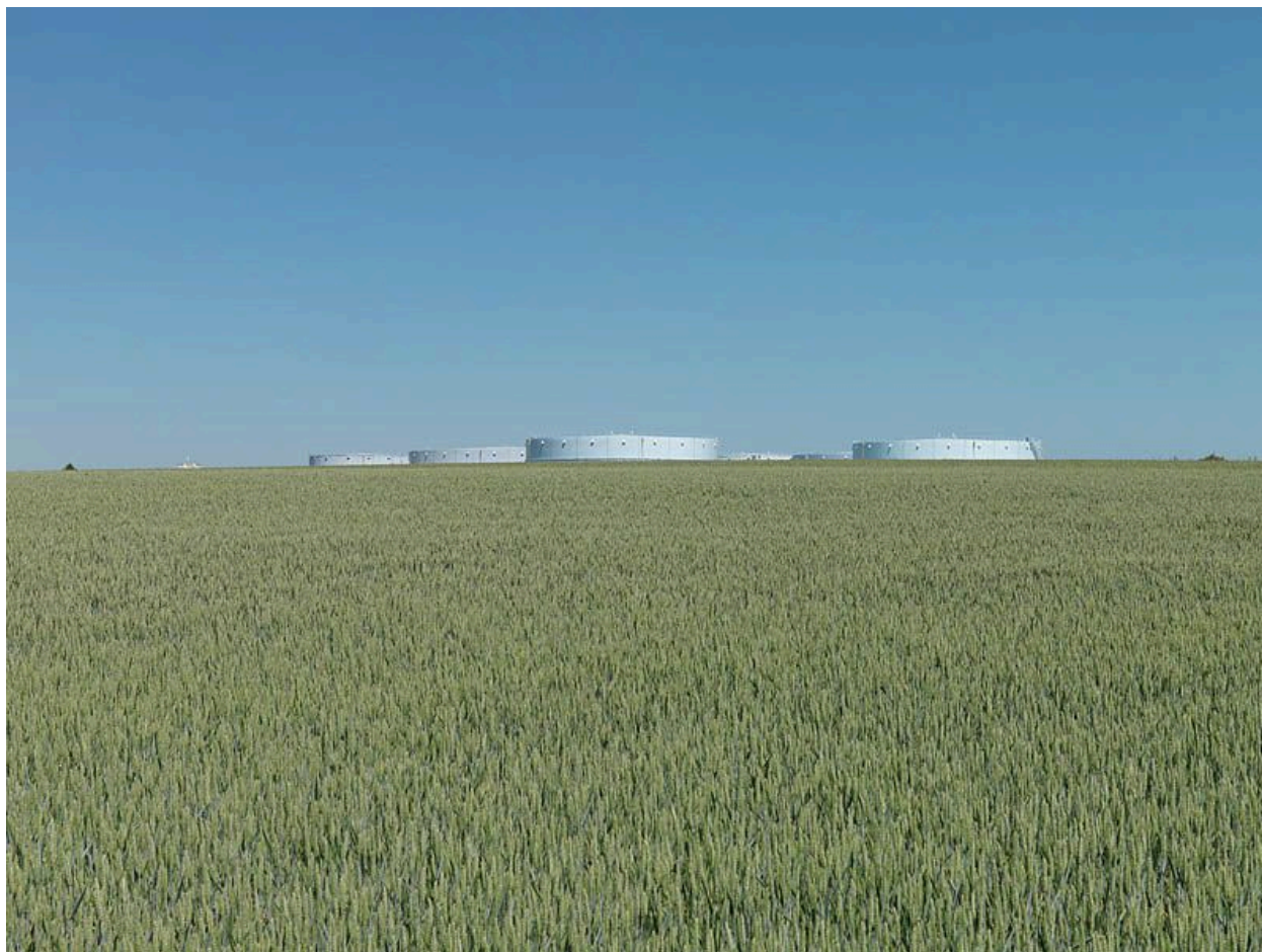
95, Épiais-lès-Louvres. Les réservoirs d'hydrocarbure.
