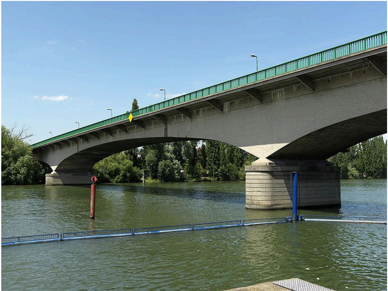
Villeneuve-Saint-Georges . Pont de Villeneuve-Saint-Georges (n°3). Vue rapprochée depuis la rive de Villeneuve-Saint-Georges.
