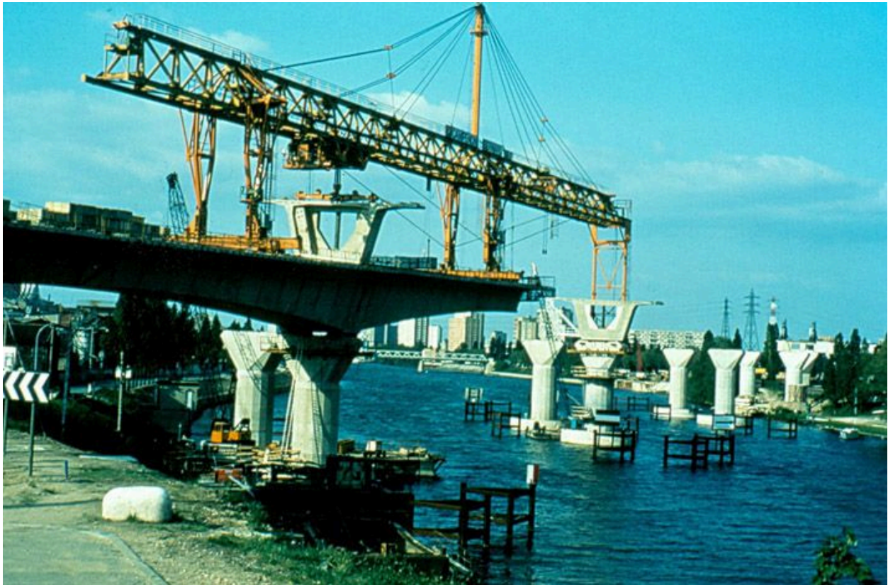
Choisy-le-Roi, Alfortville, Vitry-sur-Seine. Pont de Choisy de l'A86. Vue du chantier. Mise en place des voussoirs. Photographie. (Ecole nationale des ponts et chaussées. 2 S 039)
