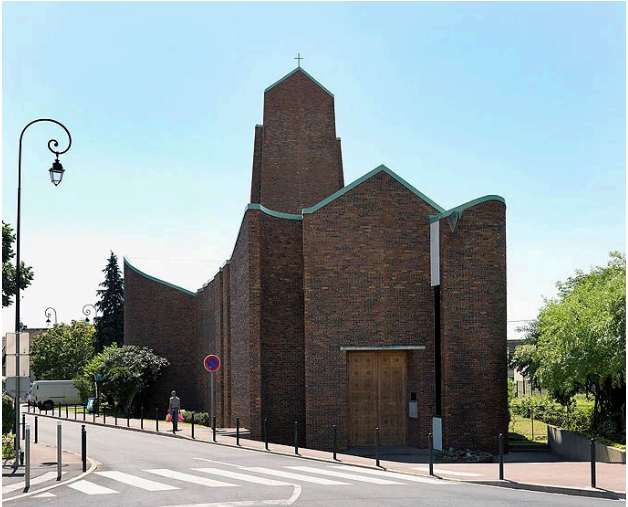
95, Garges-les-Gonesses, église paroissiale Sainte-Geneviève, rue du Colonel-Fabien. Vue de l'église du côté de l'entrée de la nef.
