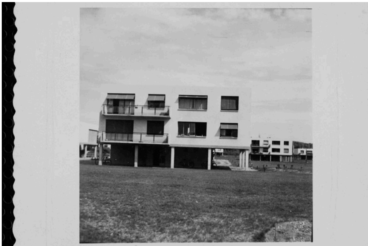
Vue d'un petit immeuble R+2 et 4 travées. (IFA Paris)
