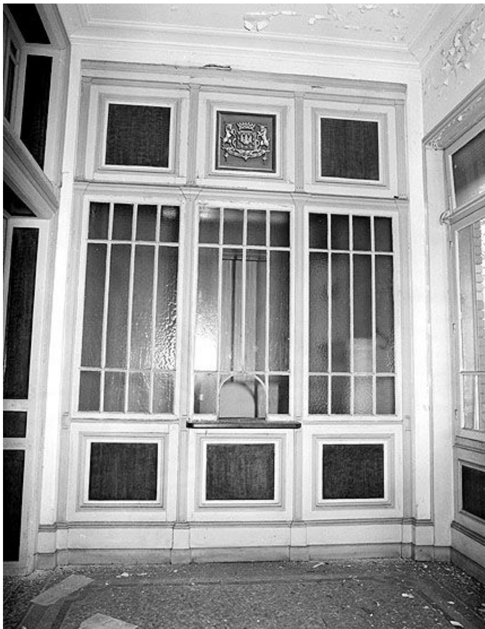
Bâtiment des bureaux, vue intérieure : guichet au premier étage. Photographie avant destruction, 1989. (Ministère de la culture, Inventaire général. 89SG724X)
