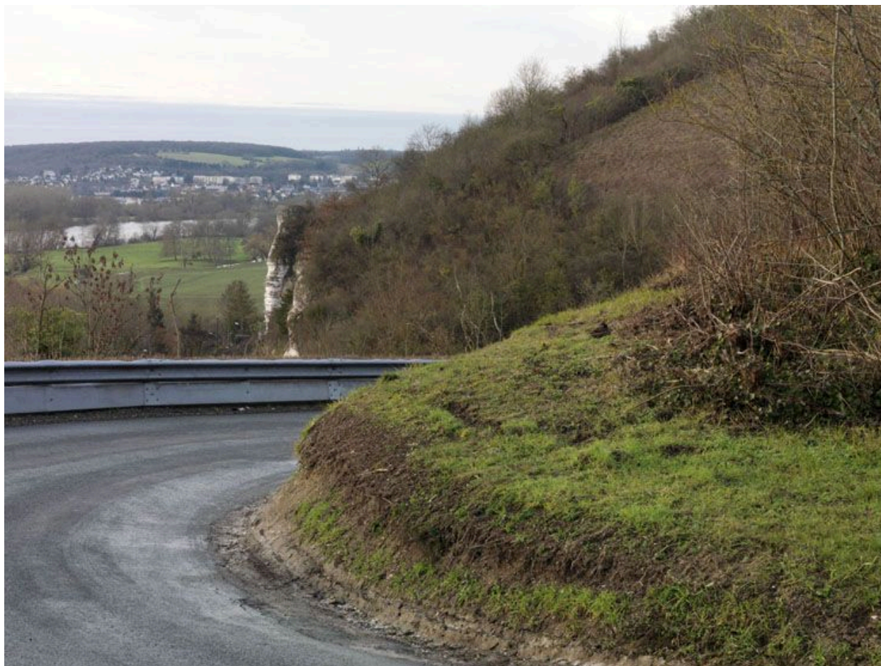
Gommecourt : route sinueuse au dessus de Clachaloze.
