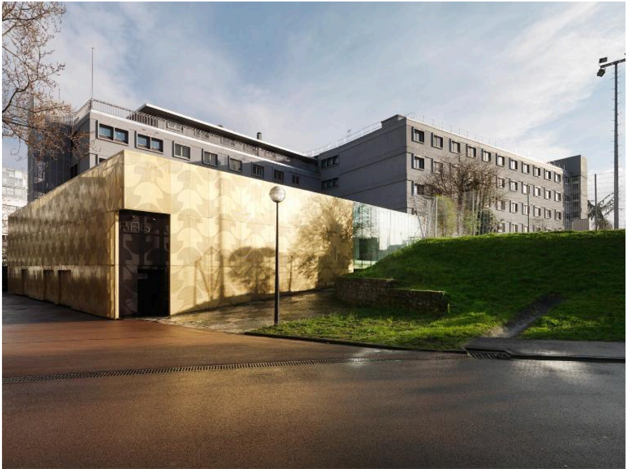
Vue d'ensemble (façade ouest).
