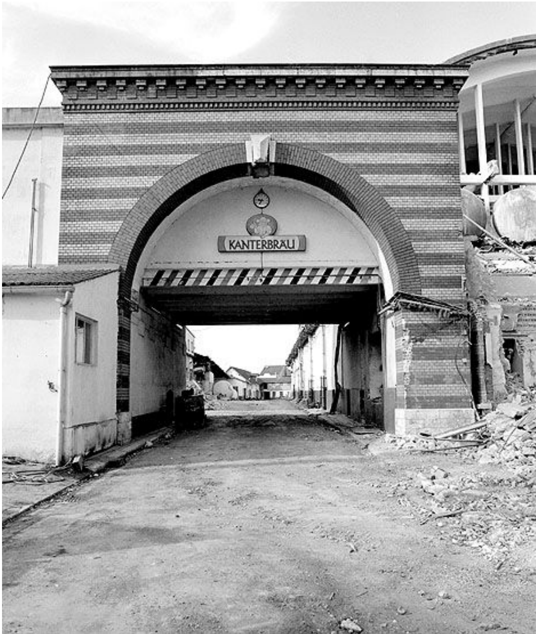
Passage couvert sous la voie ferrée. Photographie avant destruction, 1989. (Ministère de la culture, Inventaire général. 89SG697X)
