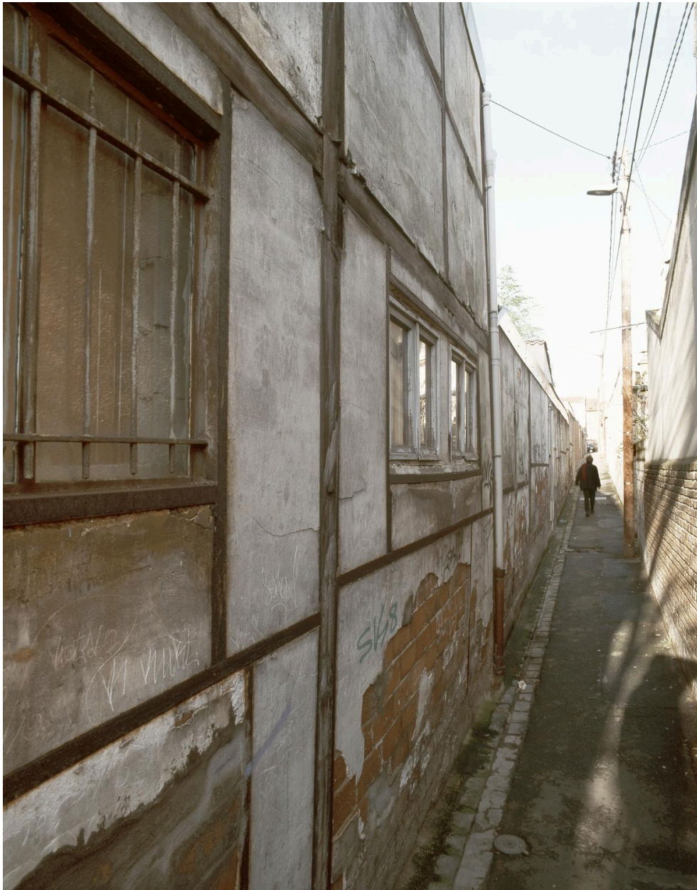
Vue d'ensemble, depuis le sud du passage Félix-Houdart.
