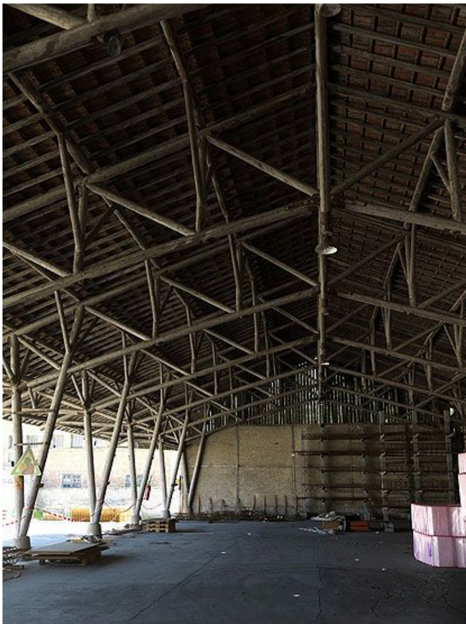
Choisy-le-Roi, entrepôt industriel de l'ancienne faïencerie Boulenger XX, 138 avenue de Villeneuve-Saint-Georges. Halle à la charpente en rondin dite canadienne.
