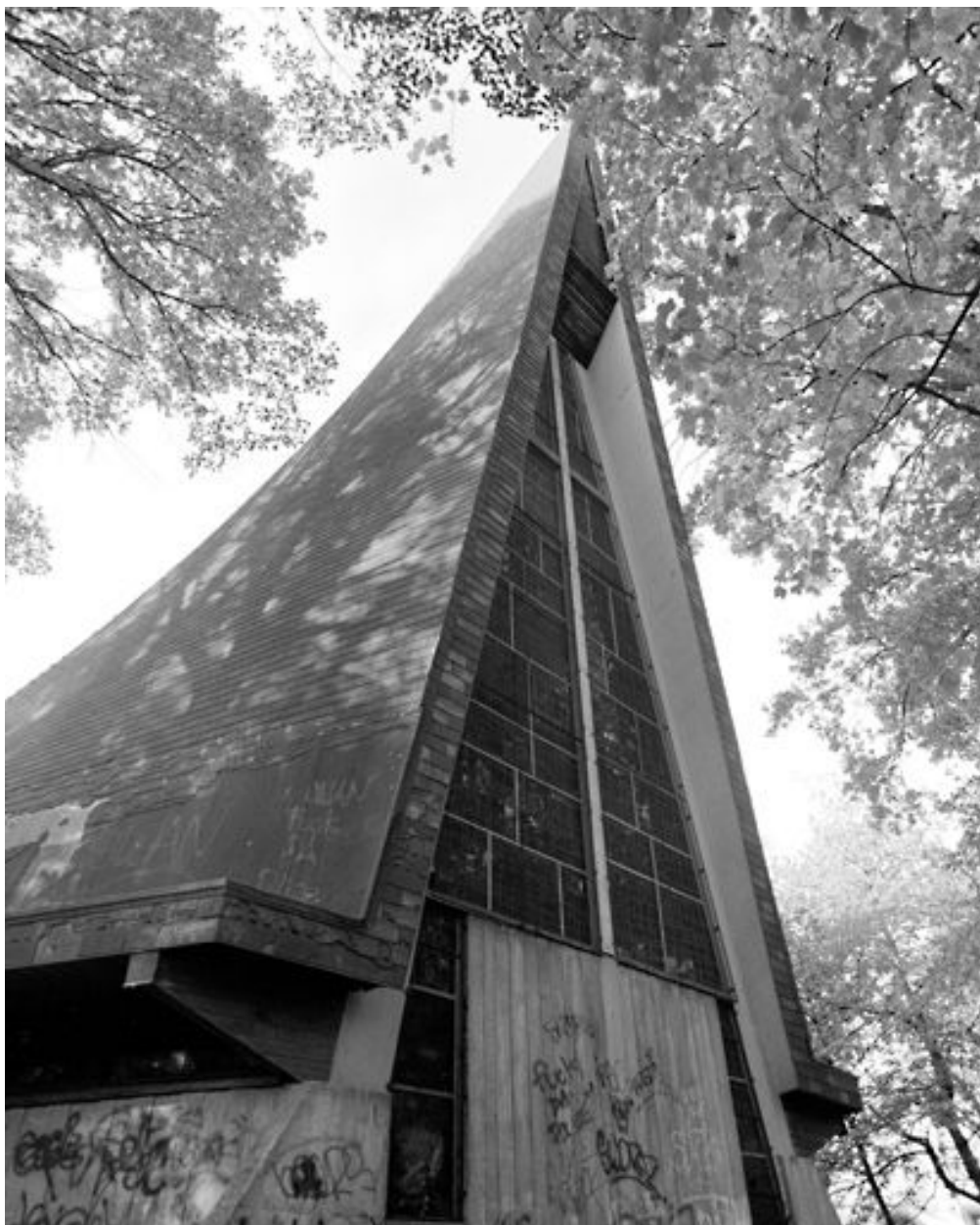
Vue de la baie du chevet.
