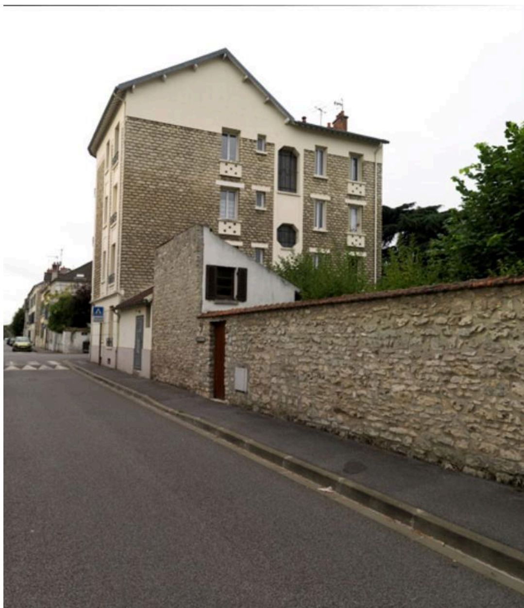
Vue de la façade arrière.
