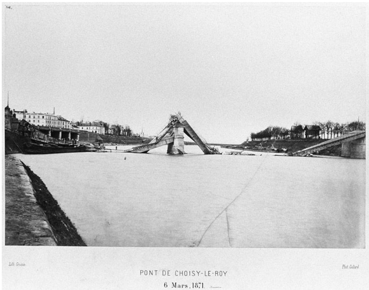
Choisy-le-Roi. Pont de Choisy (n°1). Vue depuis l'amont de la rive gauche, du pont détruit, le 6 mars 1871. Tiré de : Pont de Choisy-le-Roi, 1871, album de photographies. (Ecole nationale des ponts et chaussées. 1 S 115 Album PH 102P)
