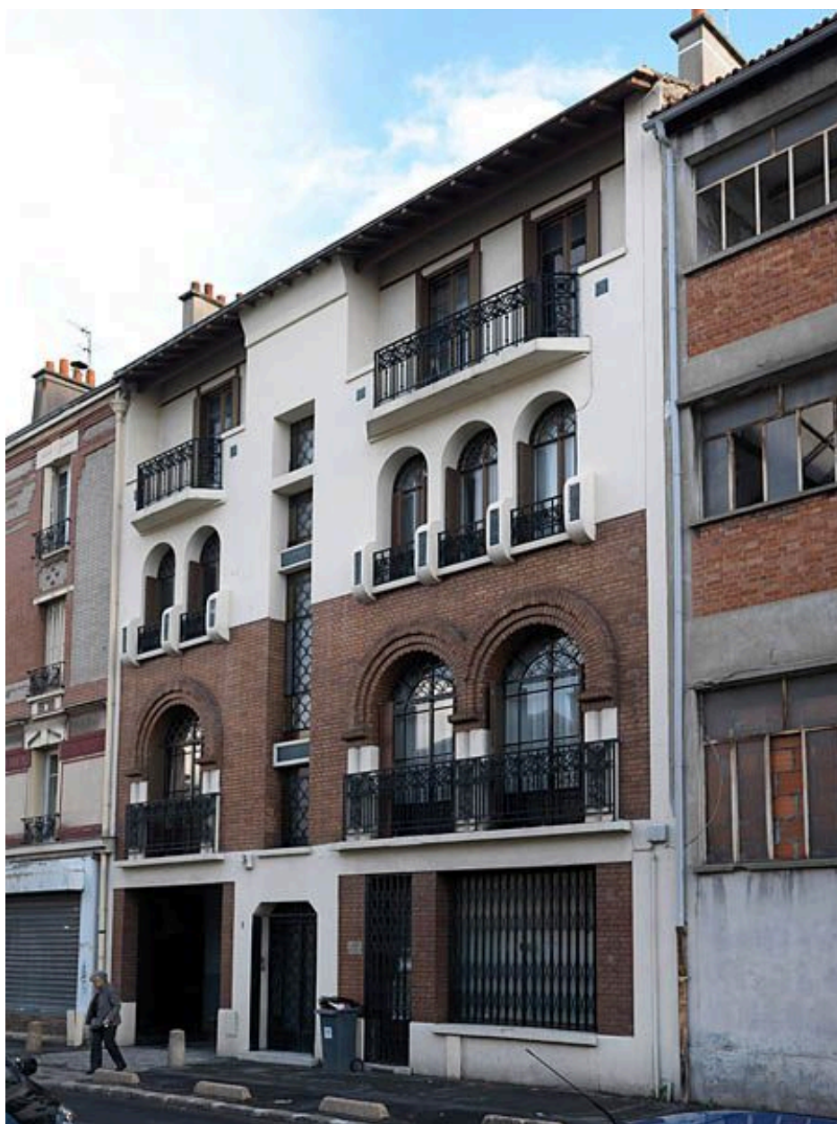
Ivry-sur-Seine, maison, 1 rue Pierre Rigaud . Vue d'ensemble.
