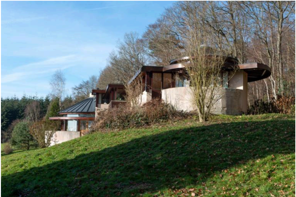
Vue latérale de la maison (côté droit).
