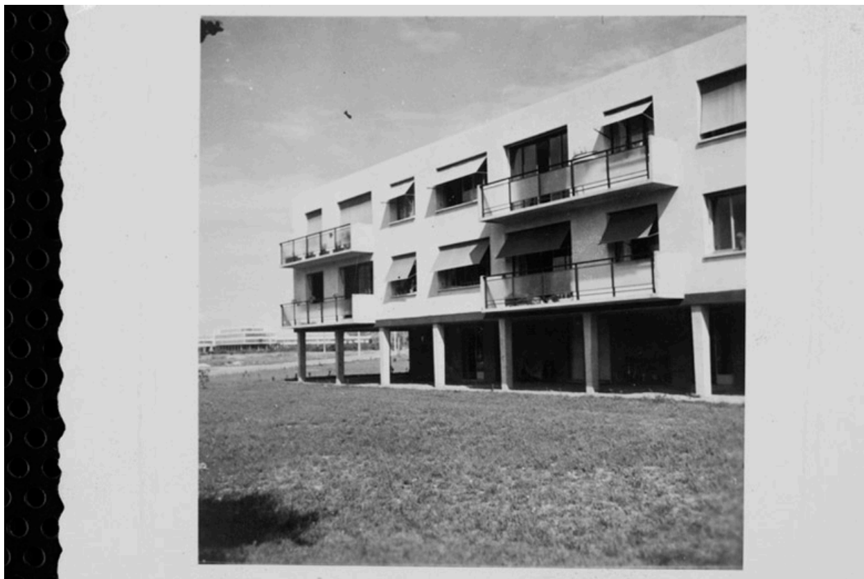
Vue partielle de la façade d'un immeuble R+2 et 9 travées. (IFA Paris)
