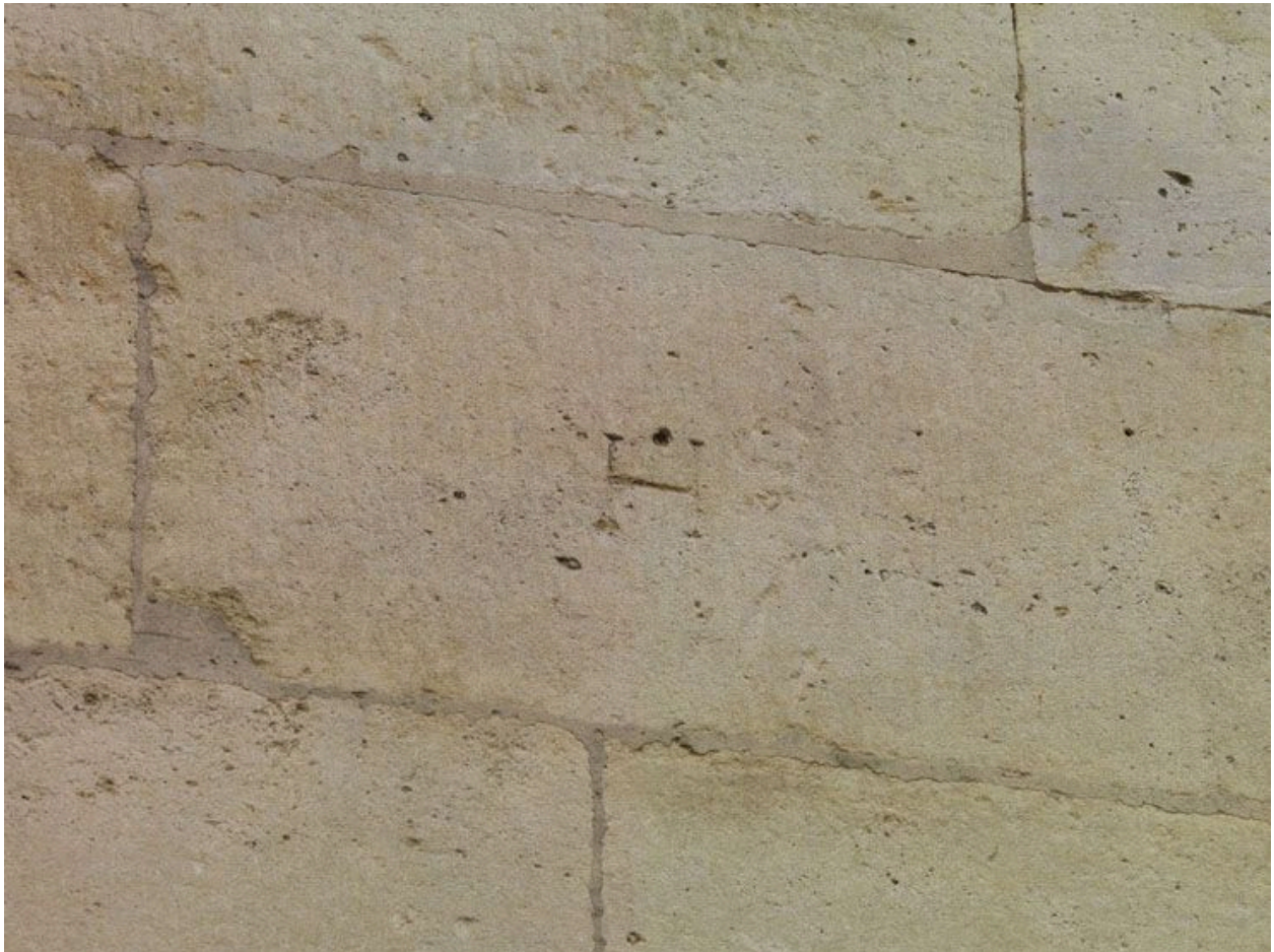
Arcueil. Marque de tâcherons (tailleurs de pierre) sur le pont-aqueduc : lettre H.
