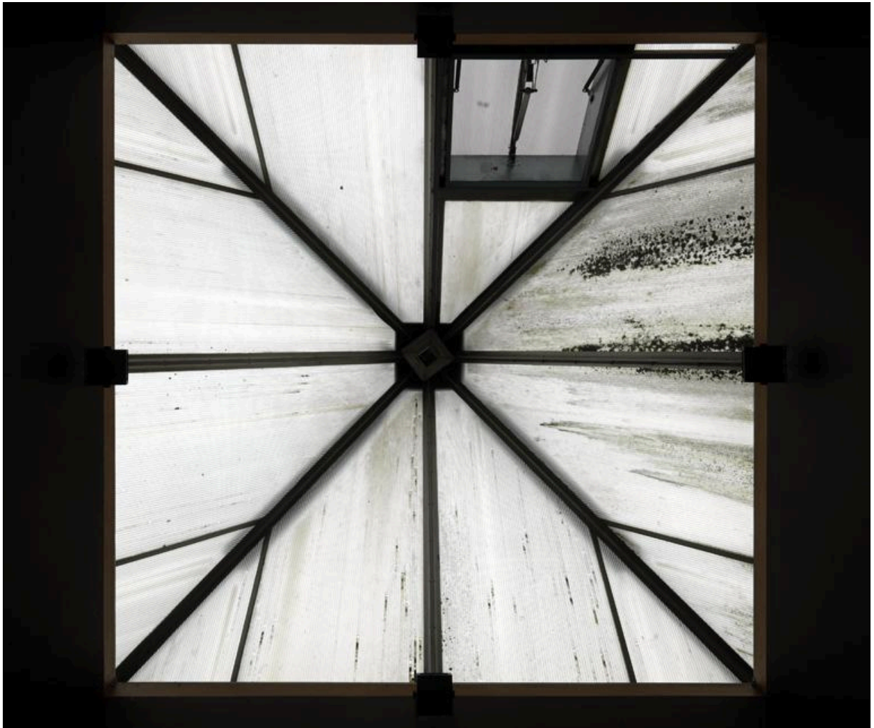
Vue intérieure de l'éclairage zénithal.
