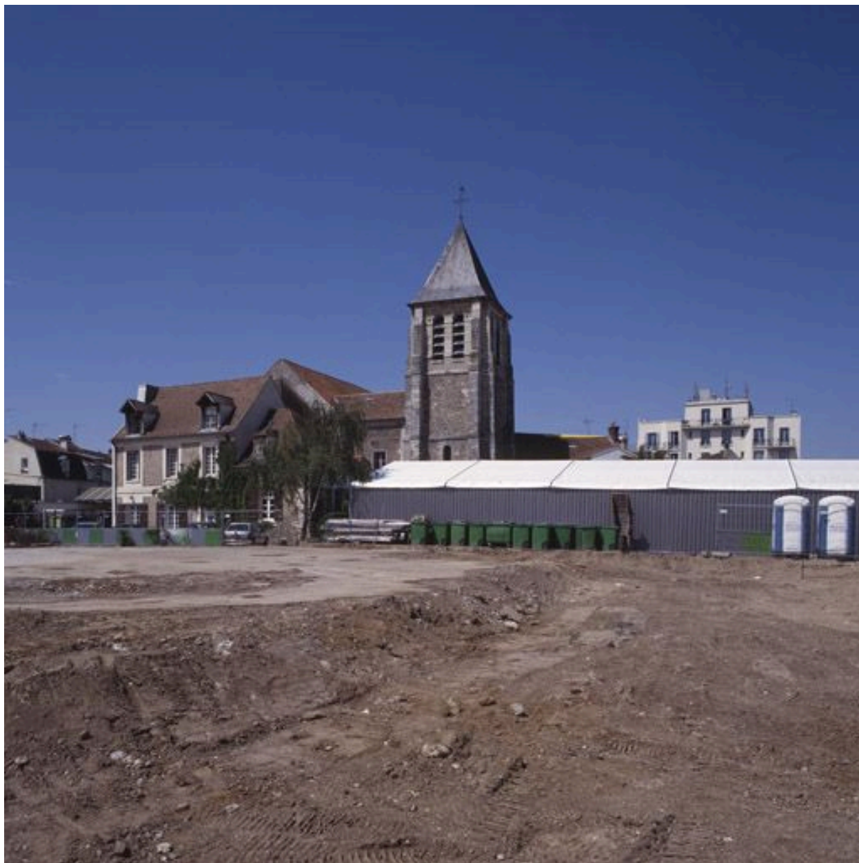
Le clocher et la façade arrière de l'église après la démolition de l'ancien marché couvert.
