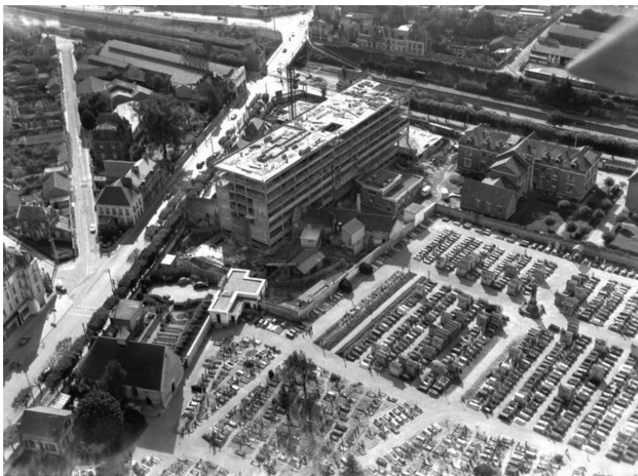
Le bloc médico-chirurgical en cours de construction. (Fonds Bertin).
