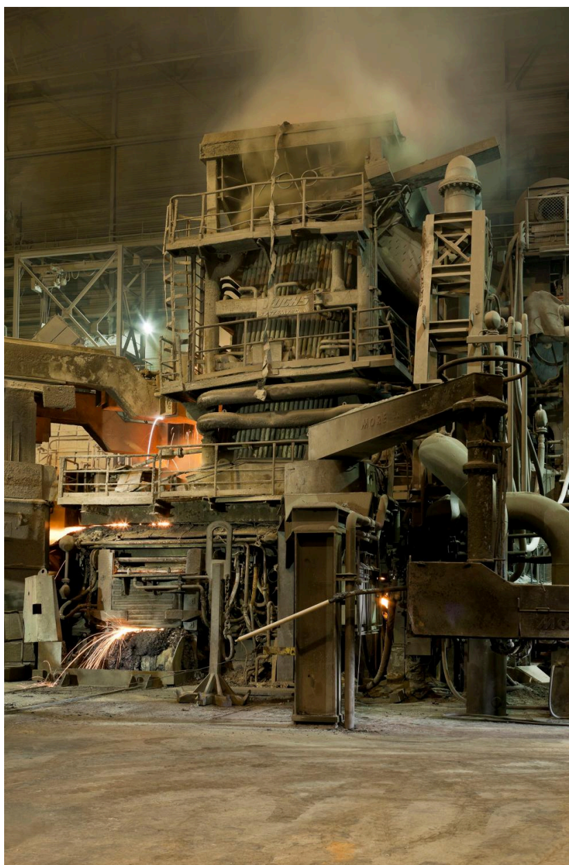
Halle du four, four à arc électrique. (réf. Département Seine-et-Marne : IVD77_2013_77_00237_NUCA)
