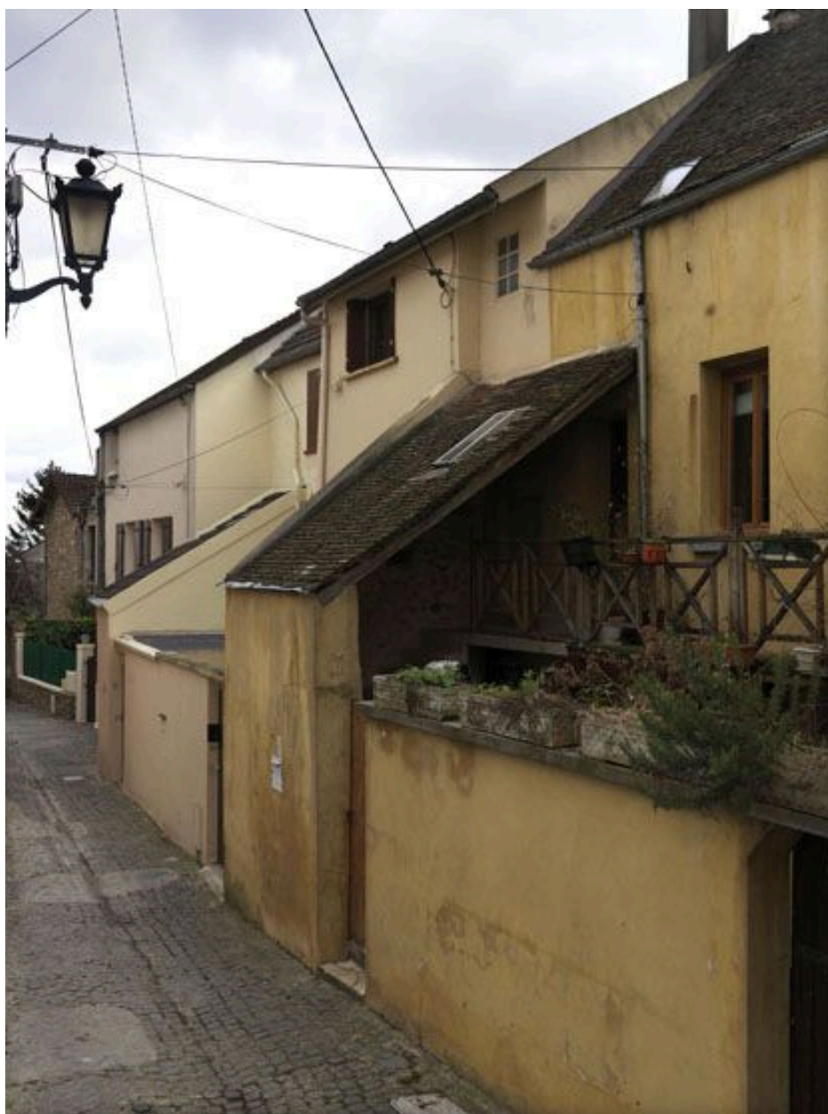
Chanteloup-les-Vignes. La rue Charles-Barrois et ses escaliers extérieurs.
