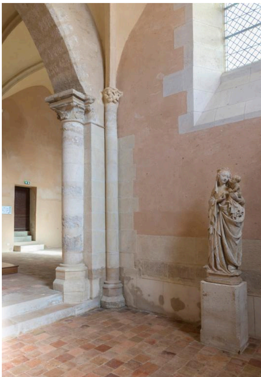
L'angle nord-est de la chapelle sud : vue vers le chœur. Structure du XIIIe siècle, remaniée au XVIe siècle dans les parties hautes.
