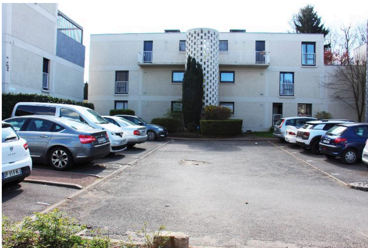
Photographie représentant un parking en plein air, attenant aux plots d'habitation.
