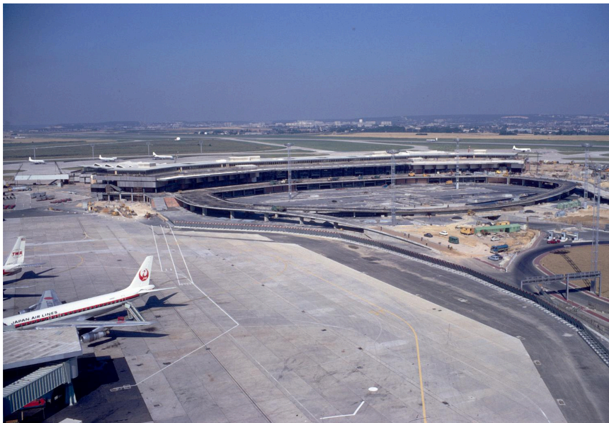
25/11/1970, construction d'Orly-Ouest (1968 1971), vue prise depuis sud est.
