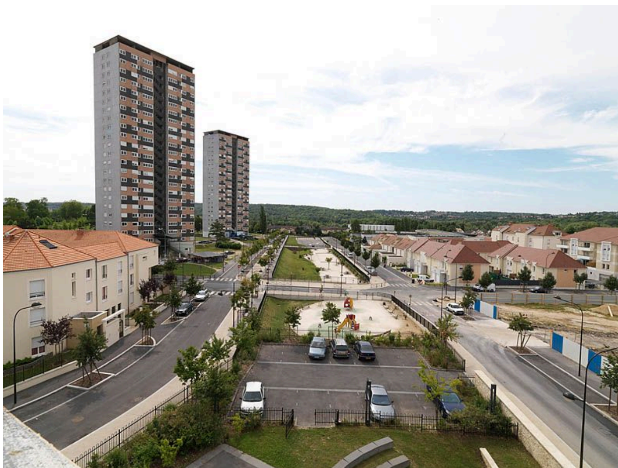
Les tours de la Pierre-Collinet. Vue d'ensemble du quartier en cours de réhabilitation.
