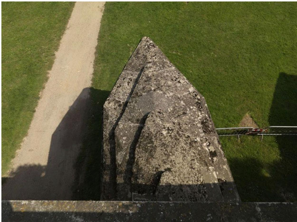
Partie supérieure d'une pile en éperon vue depuis le pont vers l'amont. Une partie de l'ouvrage enjambe des quais aménagés après un assèchement partiel du bras du fleuve.
