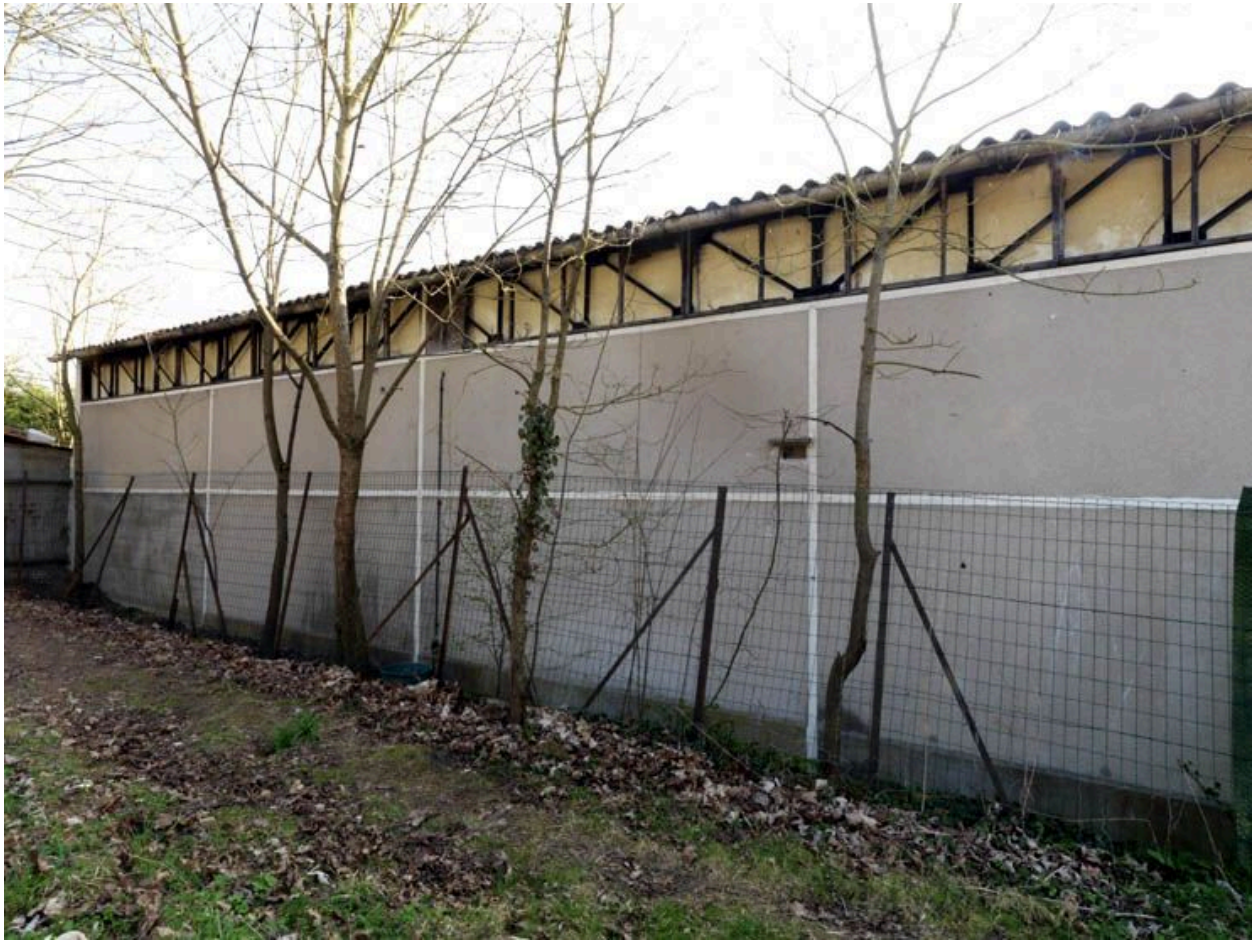
Façade arrière de l'ancien atelier d'usinage.
