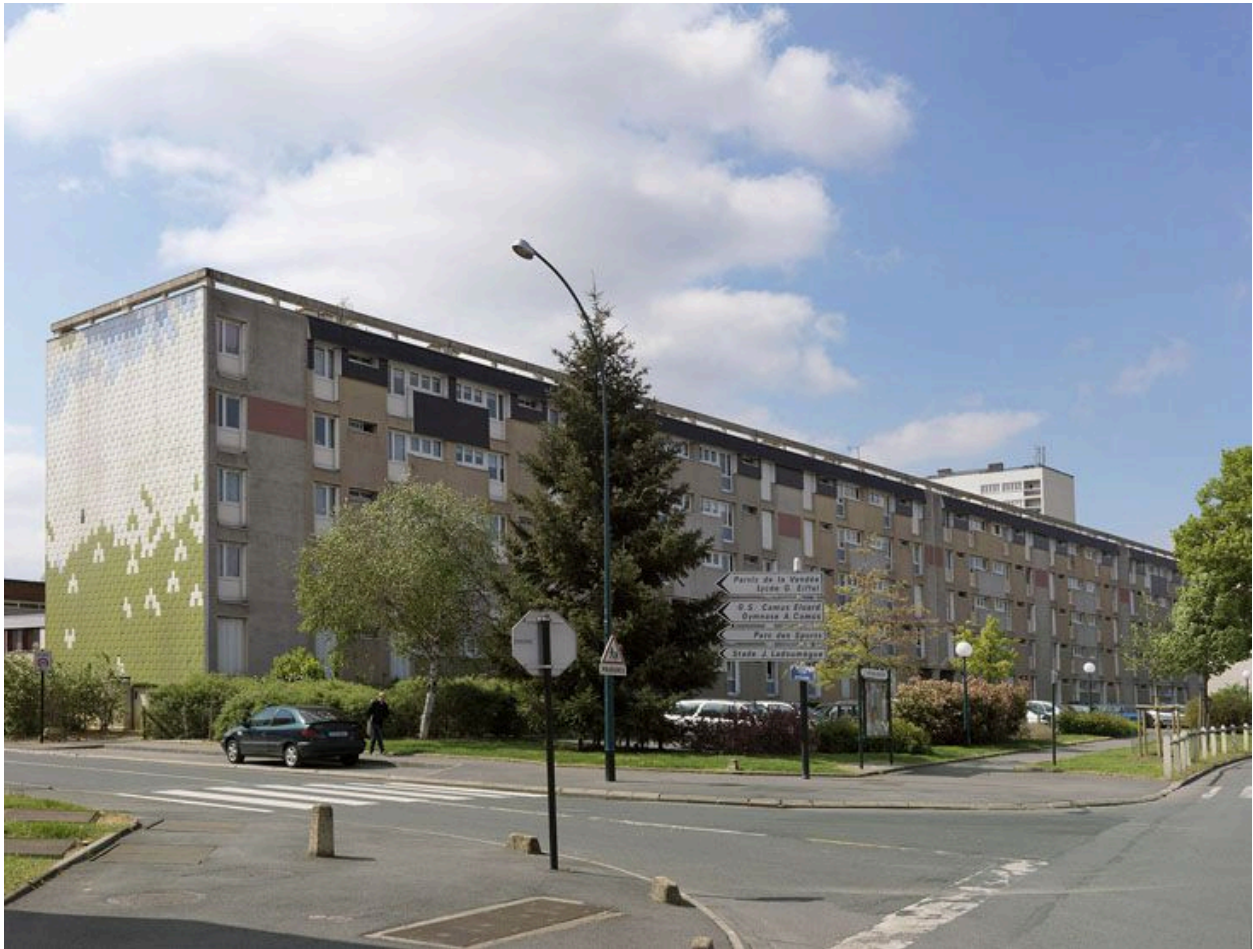
Façade arrière et pignon décoré avant rénovation de la barre A.
