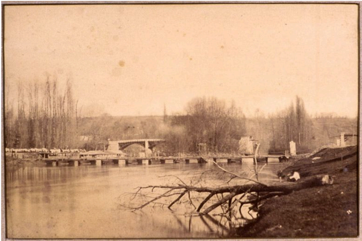
Pont de Champigny sur la Marne, détruit après la bataille de 1870 et remplacé momentanément par un pont de bateaux, au premier plan. Photographie, 1870. (Mairie Champigny-sur-Marne)
