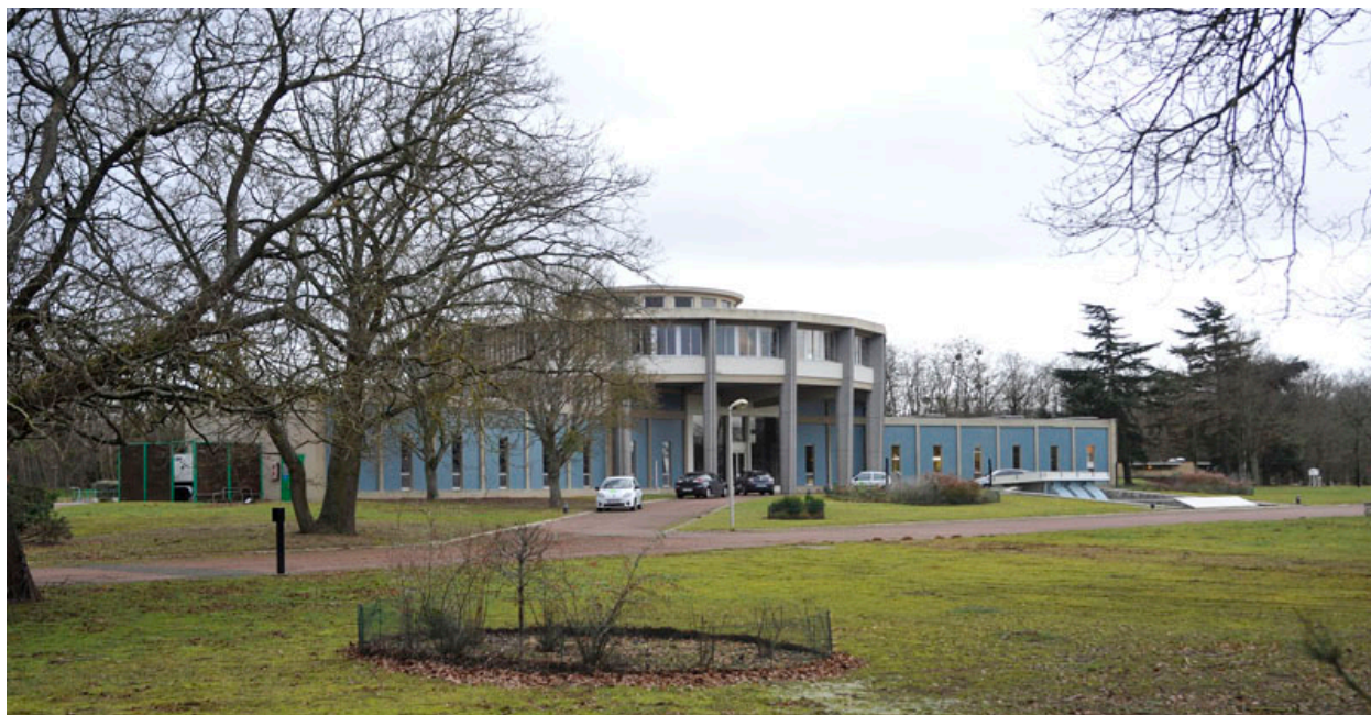
Flins-sur-Seine, station d'épuration de la Lyonnaise des Eaux-Suez Environnement, angle route des Mureaux et rue des Bois de Saint-Vincent. Vue du bâtiment administratif d'entreprise.
