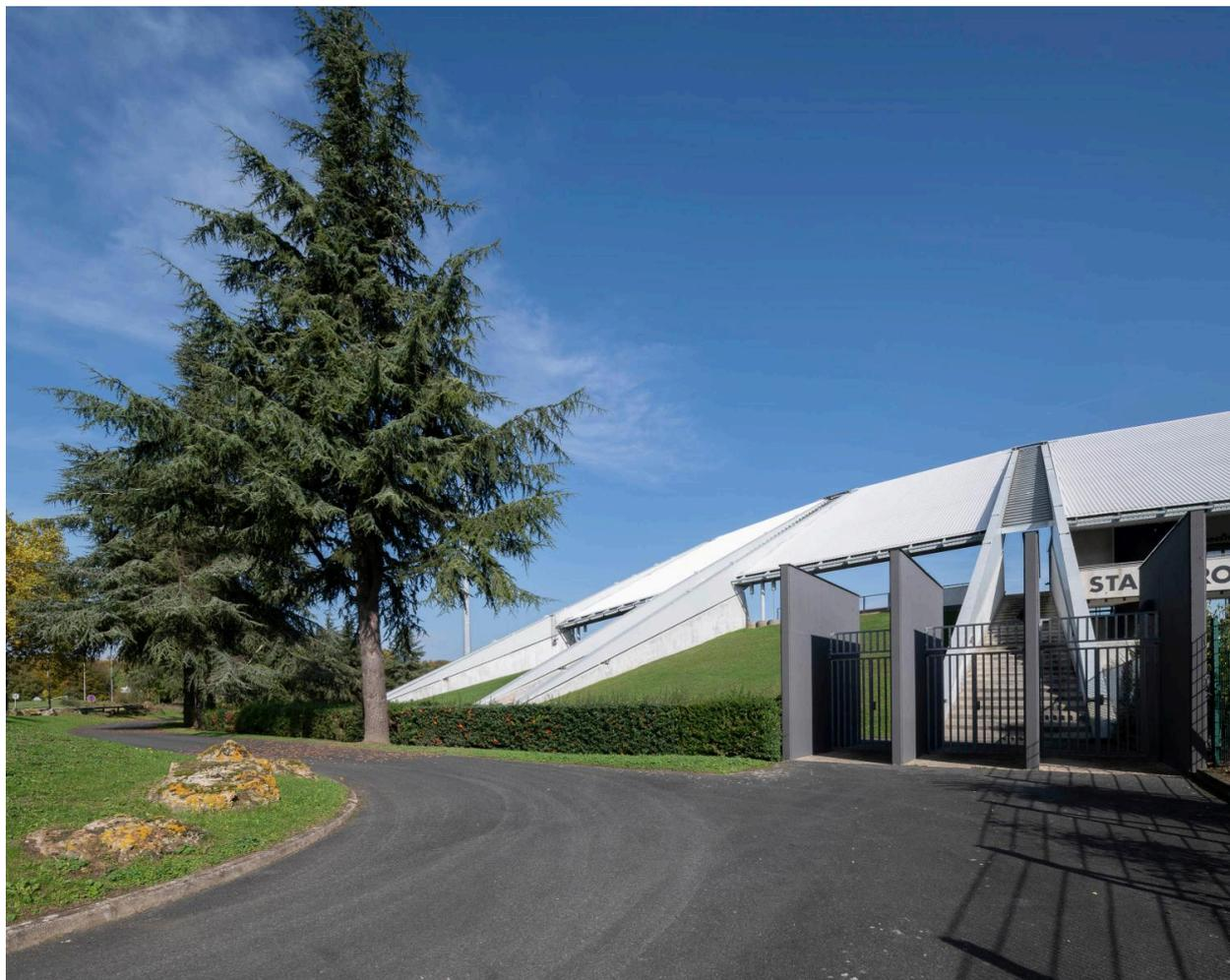
Détail des refends de béton en forme d'équerres sur lesquels repose la tribune.
