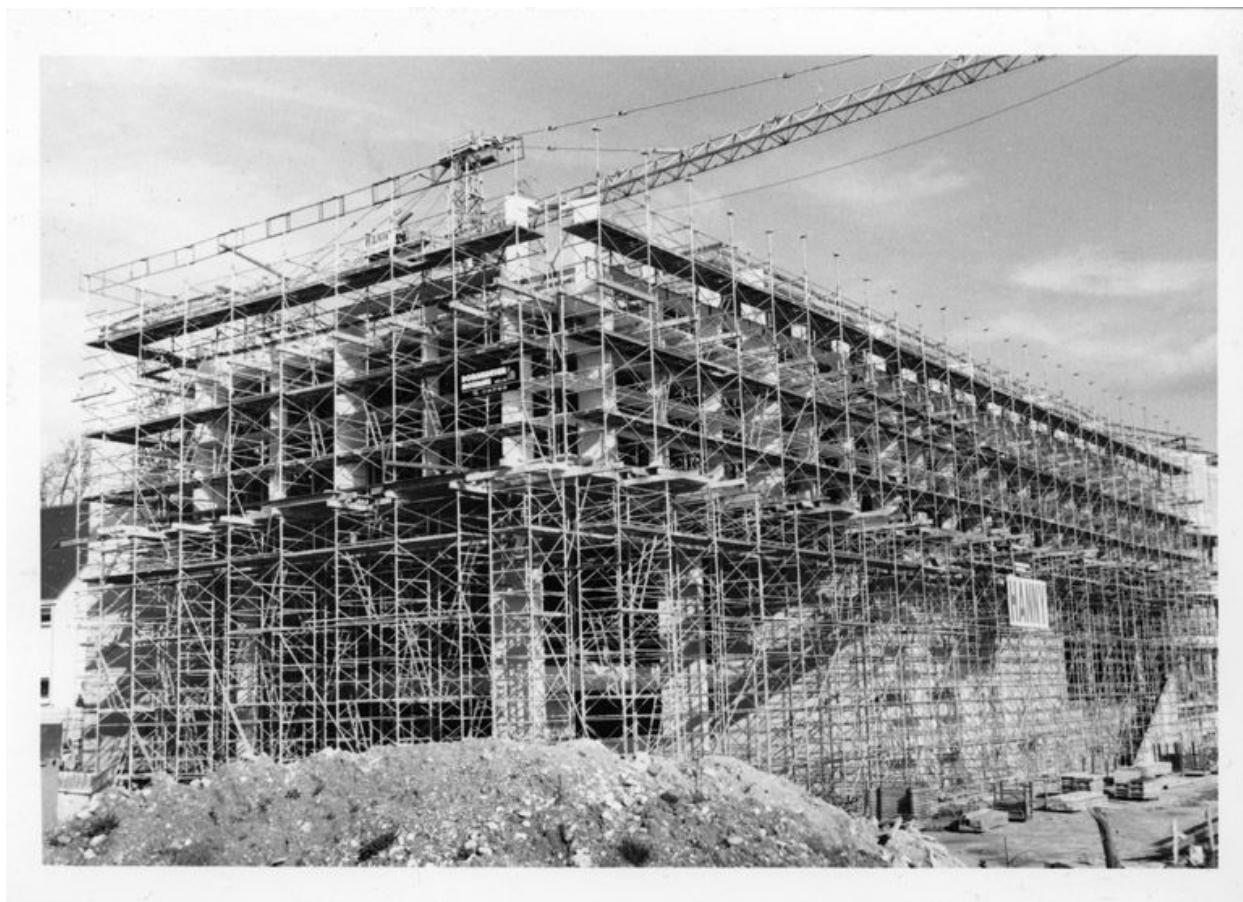
La médiathèque en cours de construction, 25 mars 2002. (Collection particulière)
