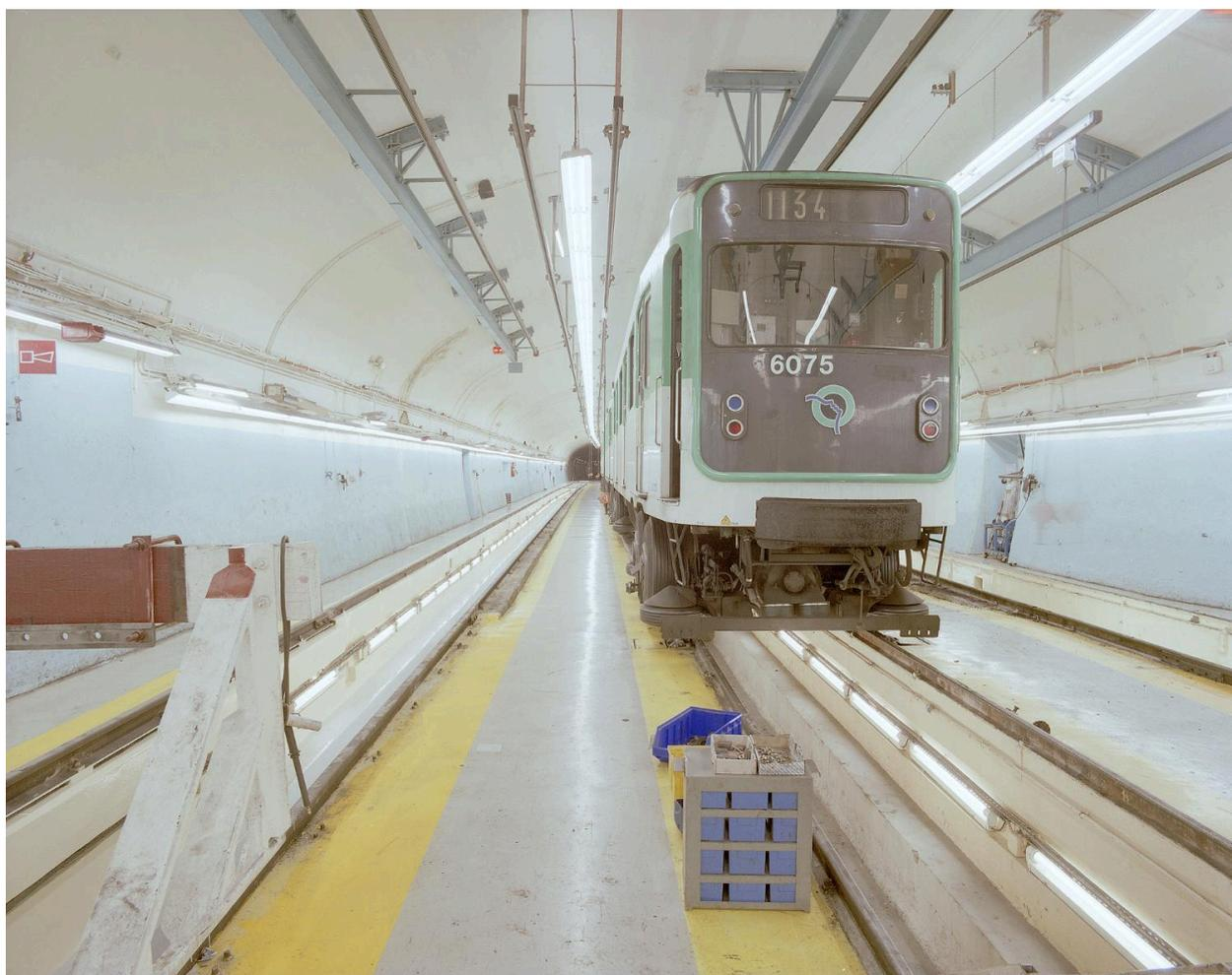
Fosses de maintenance. Train en attente. Vue prise dans l'axe du tunnel.
