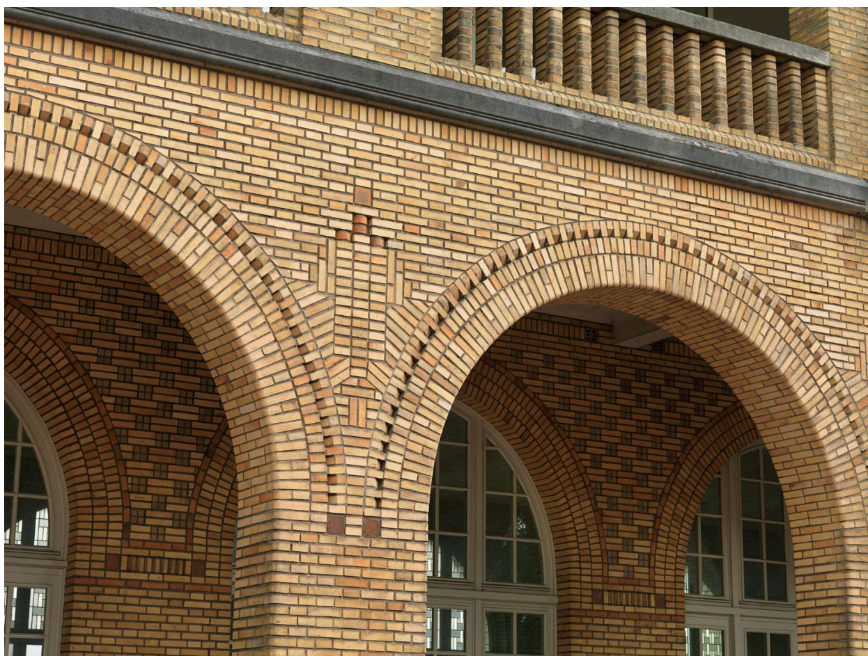
Détail du travail de calepinage de la brique ocre de Montereau.
