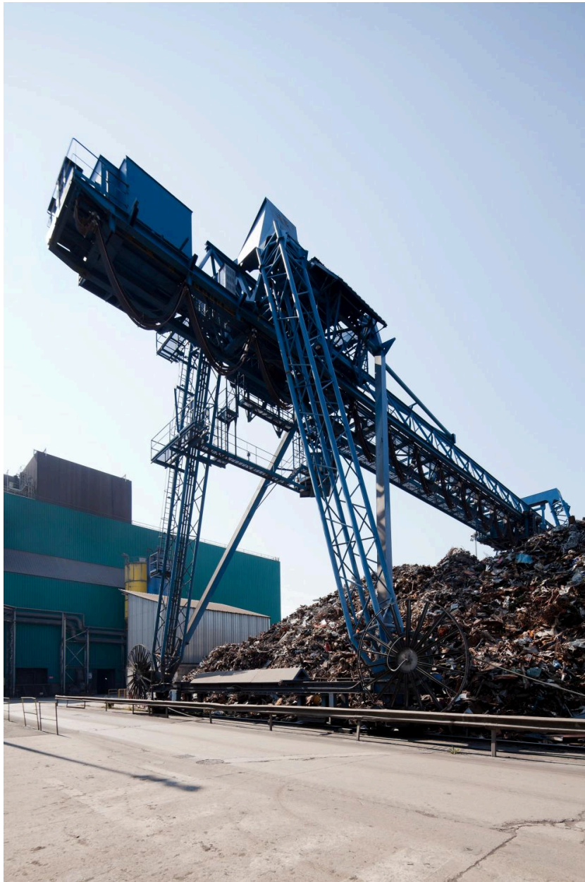
Parc à ferrailles, pont transbordeur. (réf. Département de Seine-et-Marne : IVD77_2013_77_00269_NUCA)
