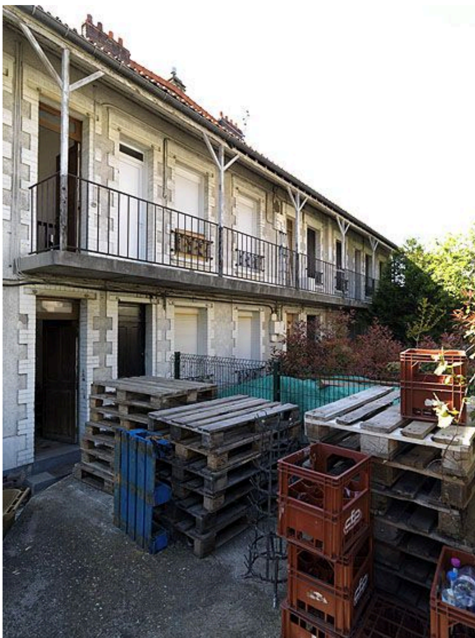
Vitry-sur-Seine, immeuble, 10-12 avenue Danielle-Casanova. Vue de la coursive desservant le 1er étage.
