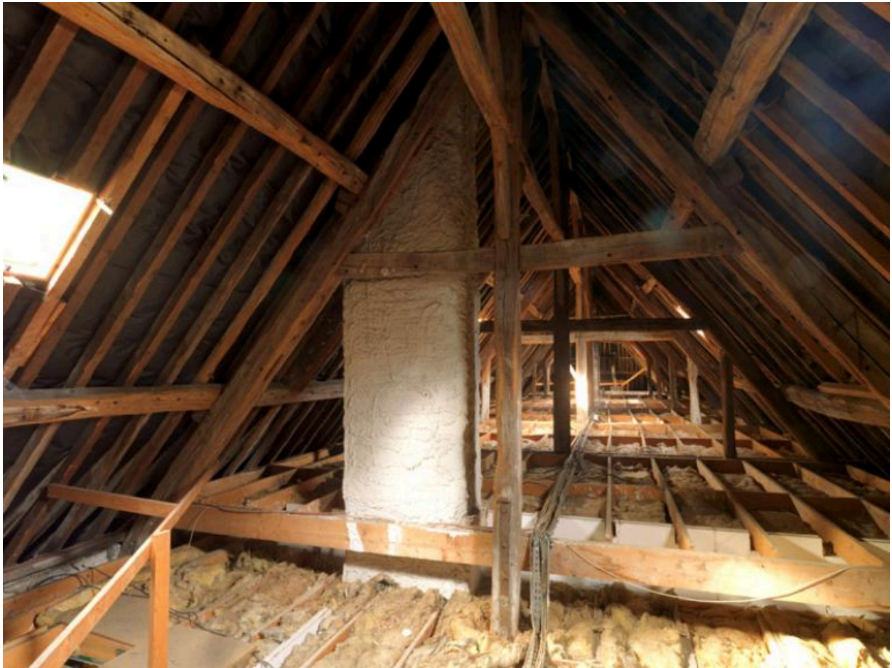
Charpente en bois avec coyaux sur la bordure gauche.
