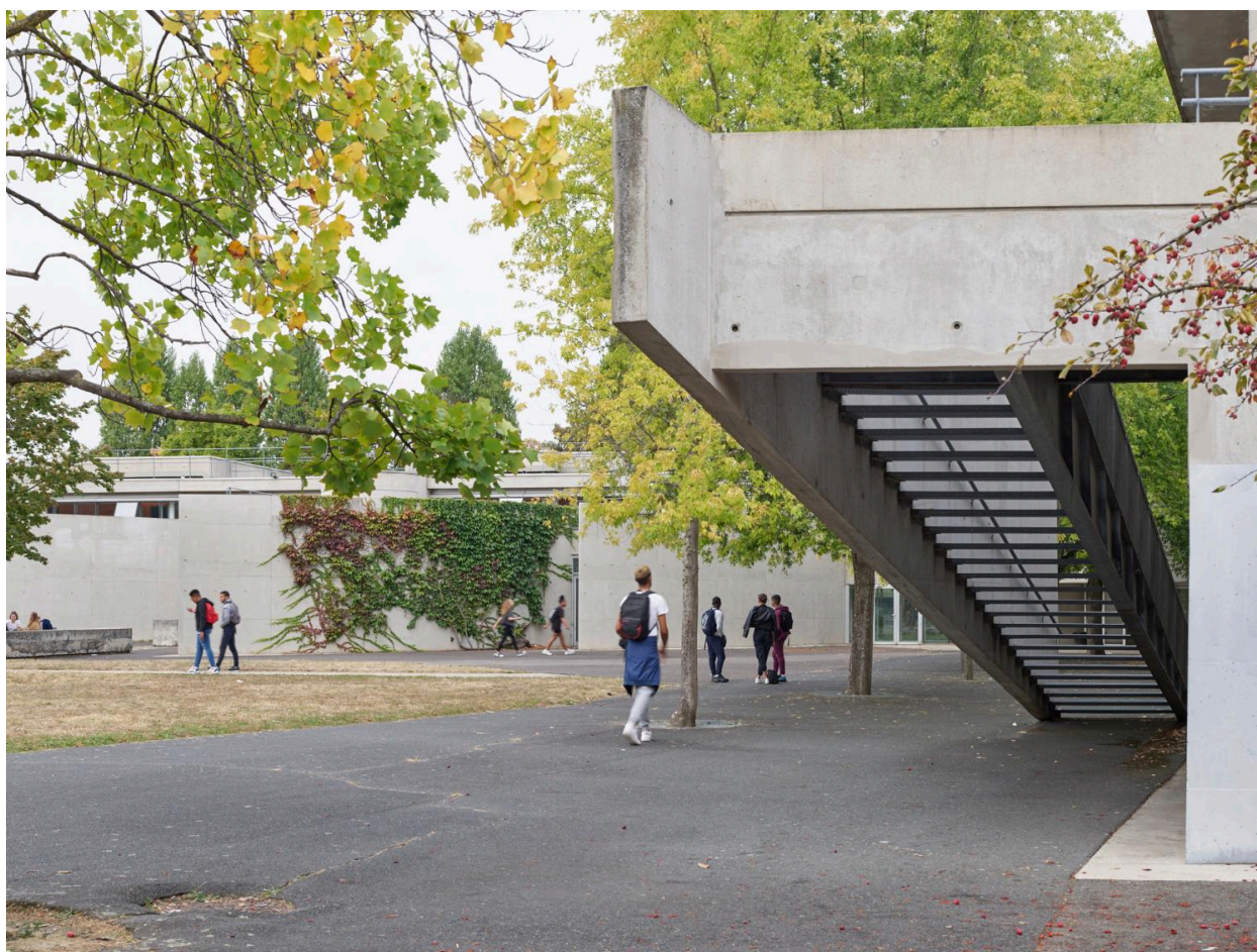
L'escalier en béton brut conduisant au CDI.
