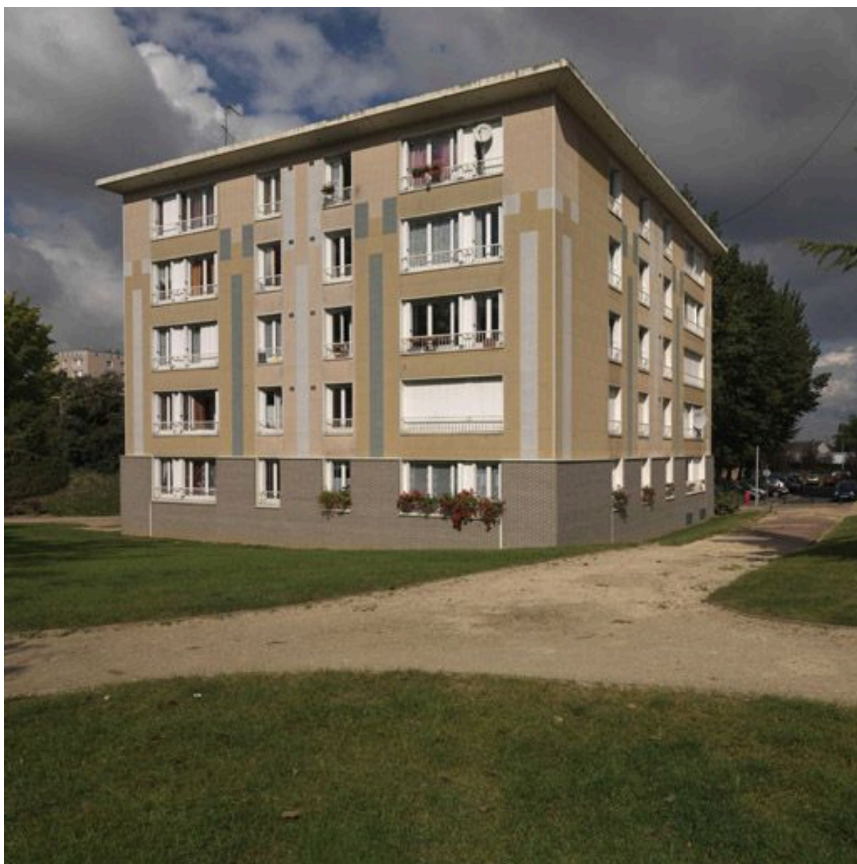
La cité des Bergeries à Vigneux-sur-Seine : façade postérieure d'un immeuble R + 4 (n° 12).
