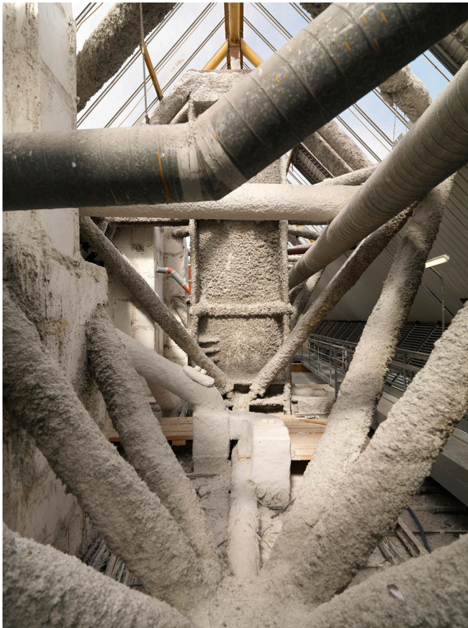
Vue de l'intérieur de la structure formant le toit des tribunes de l'hippodrome.
