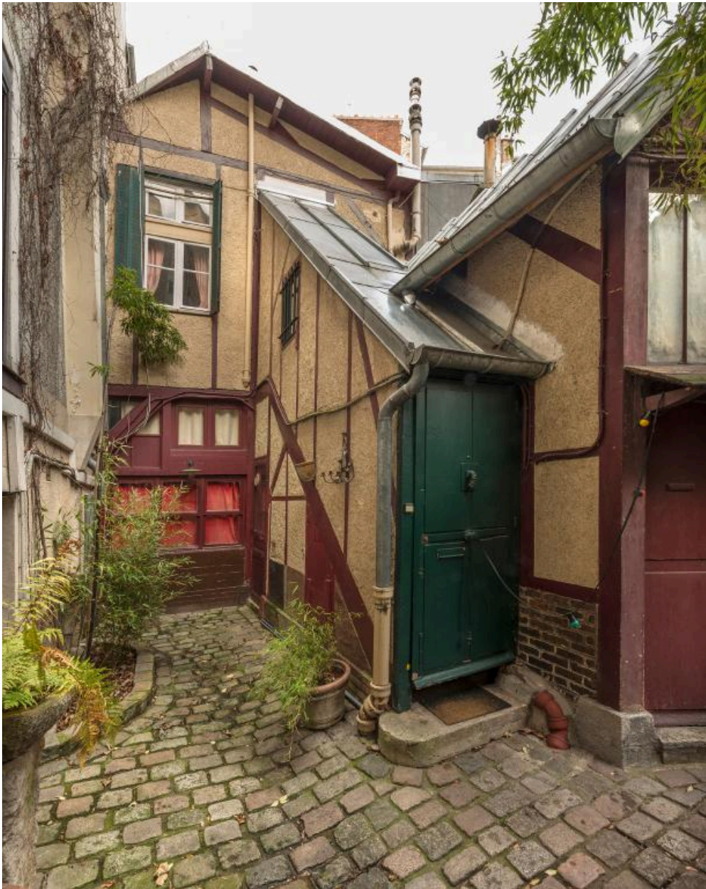
Vue d'un des ateliers et de sa cour partagée
