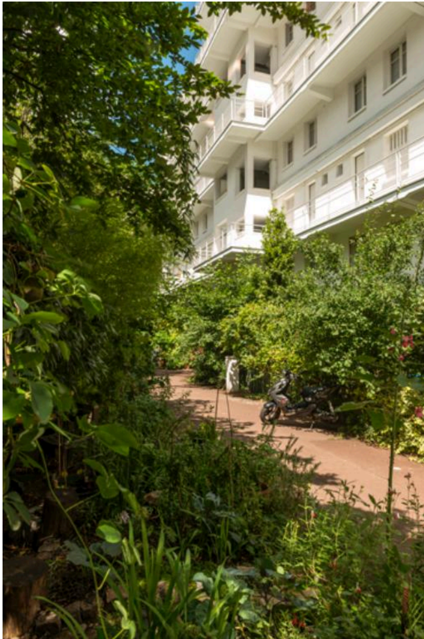
Vue de la dernière cour (bâtiment C) (2)
