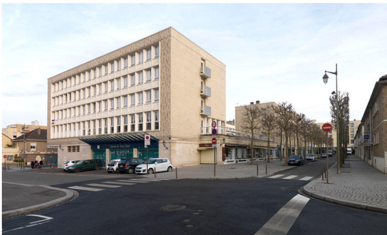
Immeuble adossé au marché, façade sur la rue Léon Marie Cesne.
