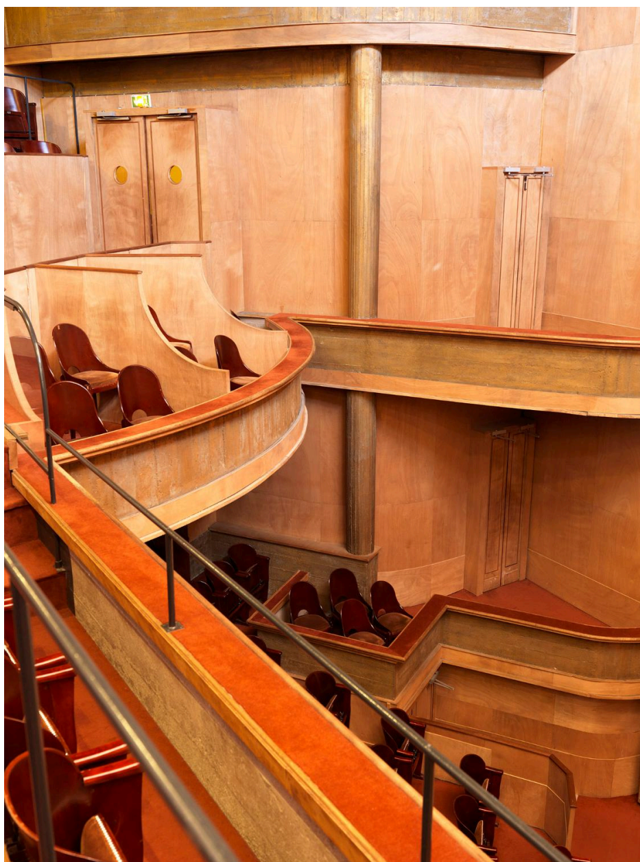
Loges, parements en contreplaqué d'okoumé, structure en béton
