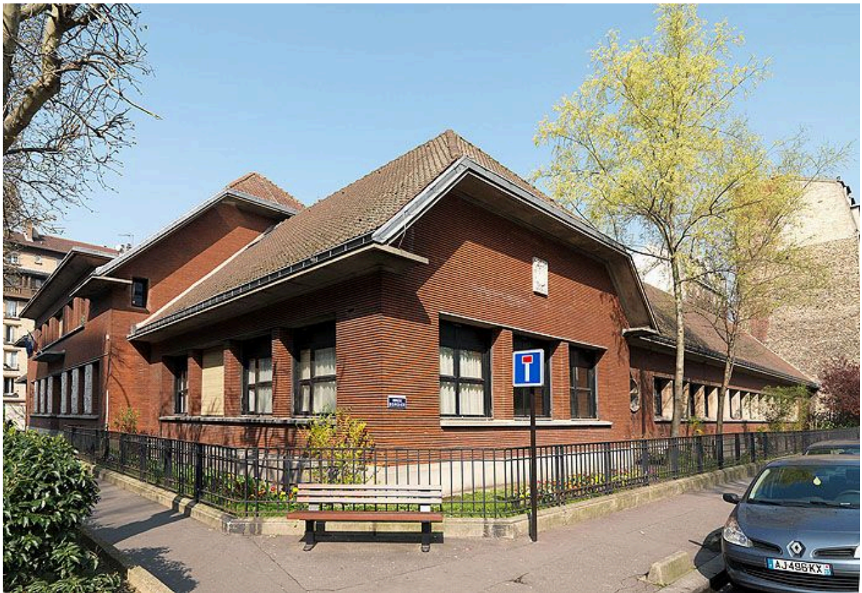
93, Aubervilliers, école maternelle Francine-Fromond, 34 rue Bordier. Vue d'ensemble de l'école.
